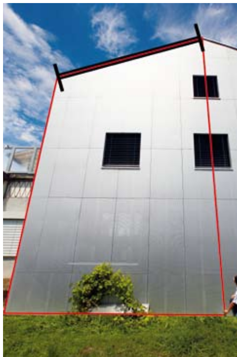
Funkcja trapezu umożliwia łatwe prowadzenie pomiaru np. pochyłości dachów.
